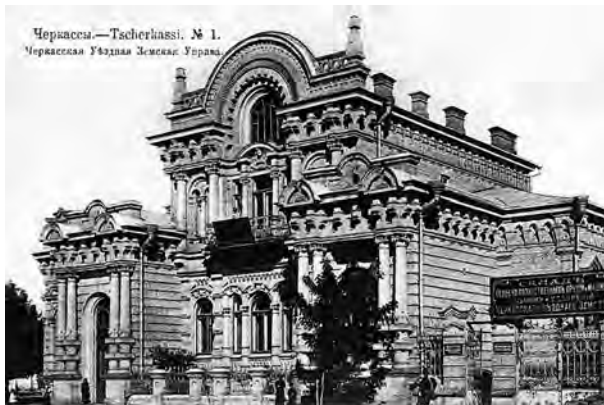
Приміщення Черкаського повітового земства
