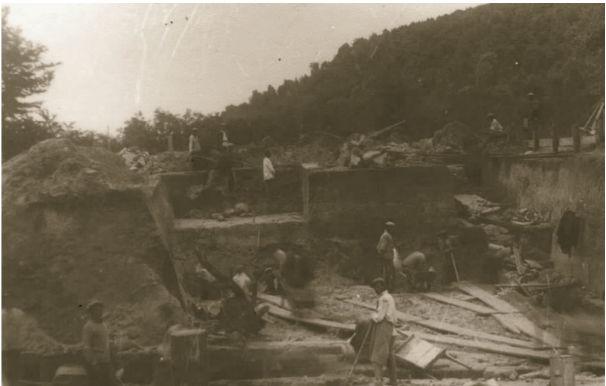
Початок будівництва музею Т. Г. Шевченка на Тарасовій горі. 1930-і рр.
