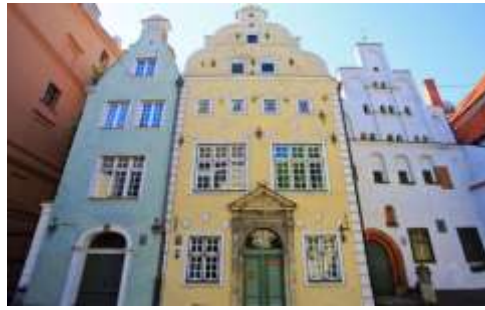
Рис. В. 10. Будівля «Три брати»
