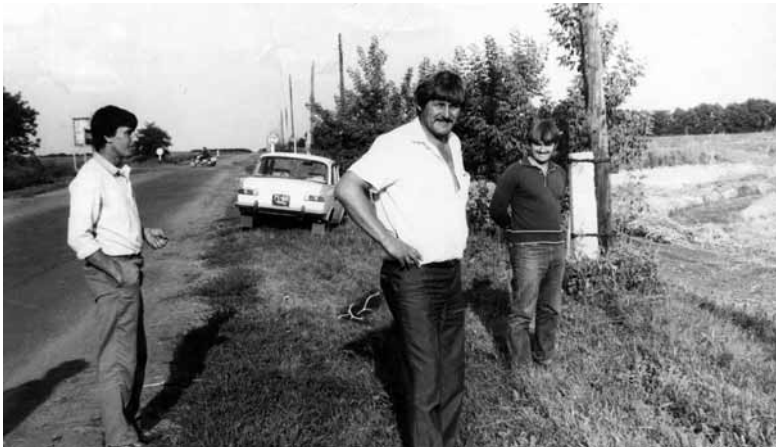
Дорога на Плешкані
