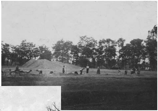
Закладка фундаменту нової школи. Кінець 1950-х рр.
