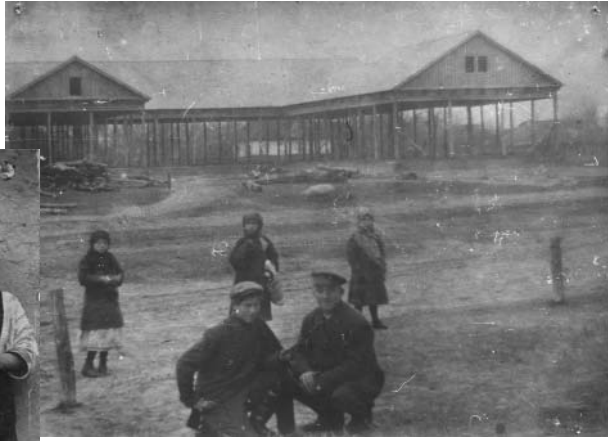
Будівництво нового приміщення школи. Поч. 1930-х рр.
