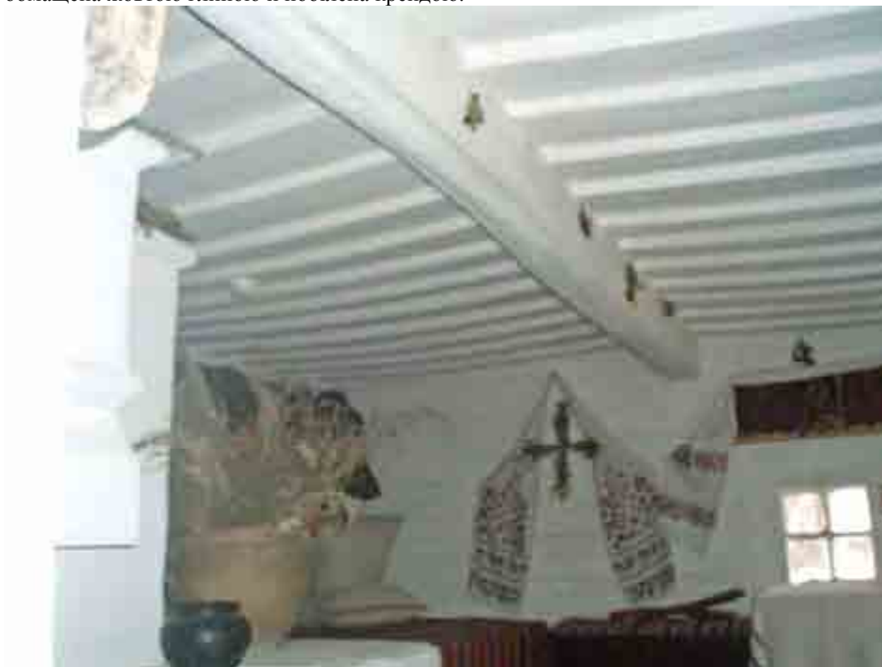
Стеля з поздовжнім сволоком. Батьківська хата Т.Шевченка.
