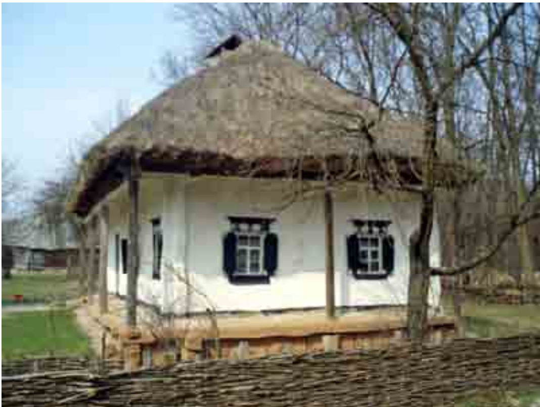
Вигляд з причілка.
