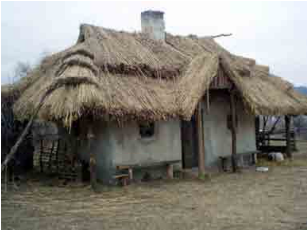
Хата з ганком і притулою. Отоплювалась "по білому". Вікна мають по чотири шиби. Покрита очеретом, на рогах покладені китиці.
