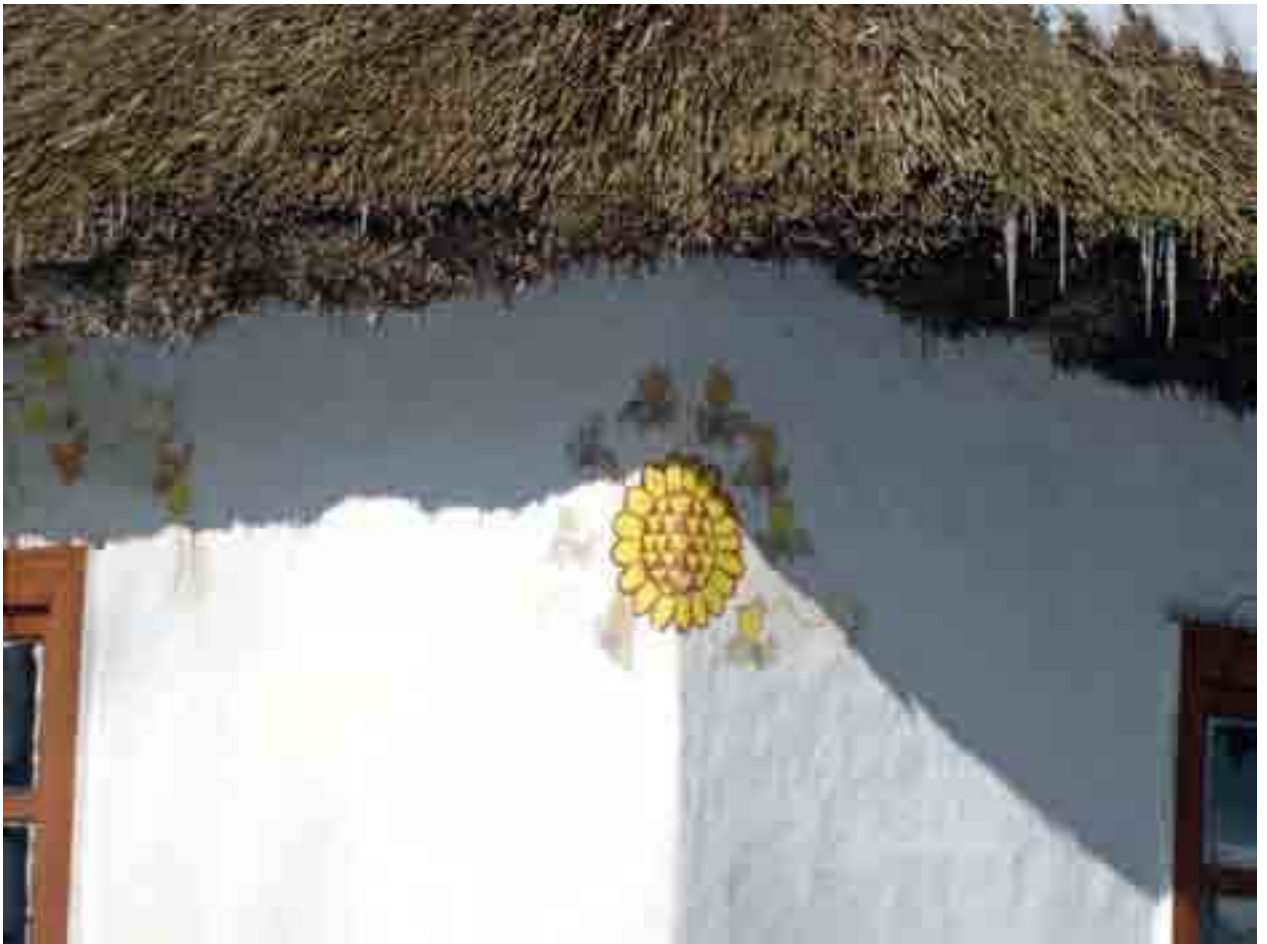
Розпис на розі чільної й причілкової стін.
