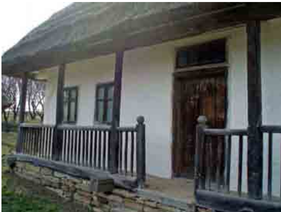
Галерея на фасаді хати.
