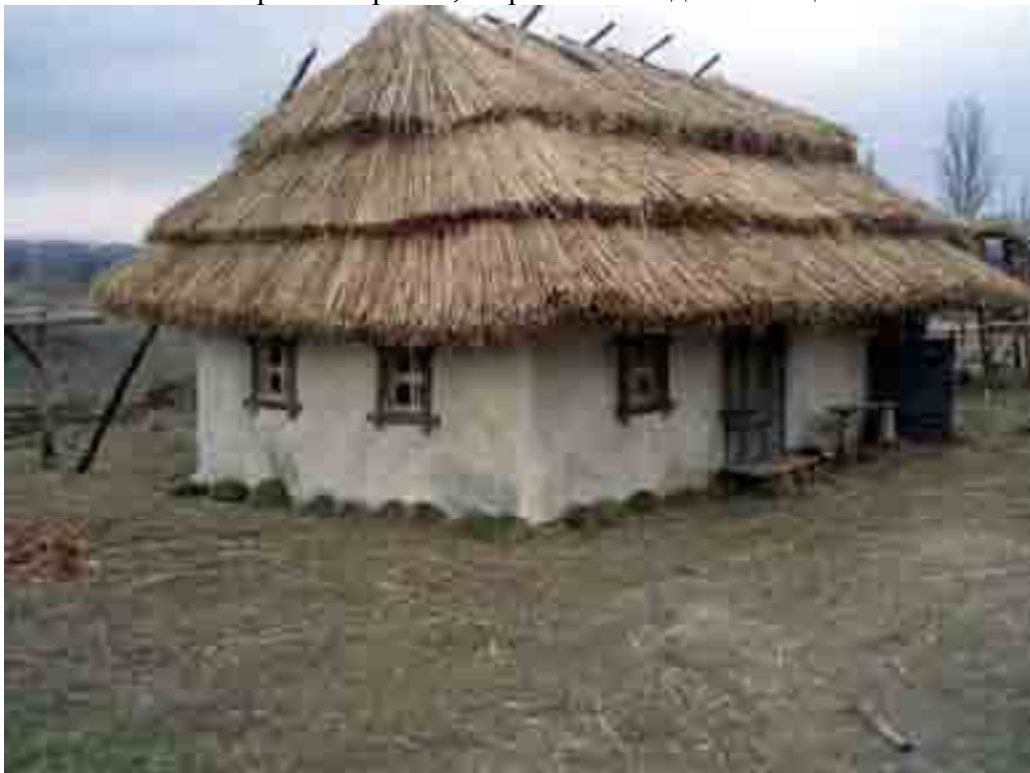
Хата козацької доби. Опалювалась "по чорному". Дах покритий очеретом. Ступінчасте покриття.
