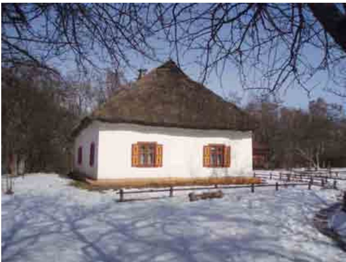
Вигляд з причілка.
